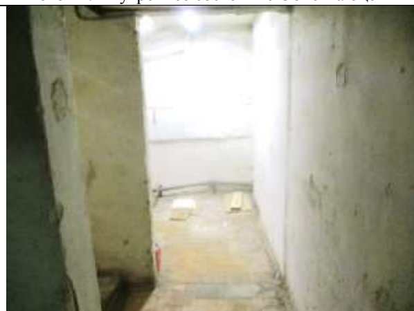
Фото 24. Внутреннее состояние Объекта оценки
