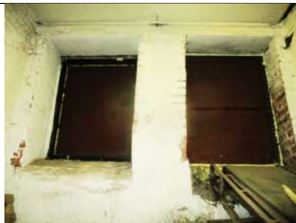
Фото 34. Внутреннее состояние Объекта оценки
