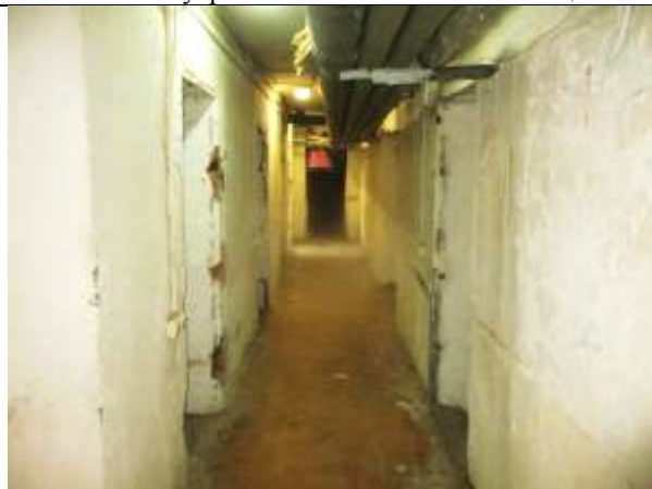
Фото 29. Внутреннее состояние Объекта оценки
