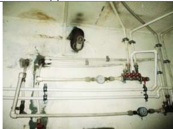
Фото 40. Внутреннее состояние Объекта оценки
