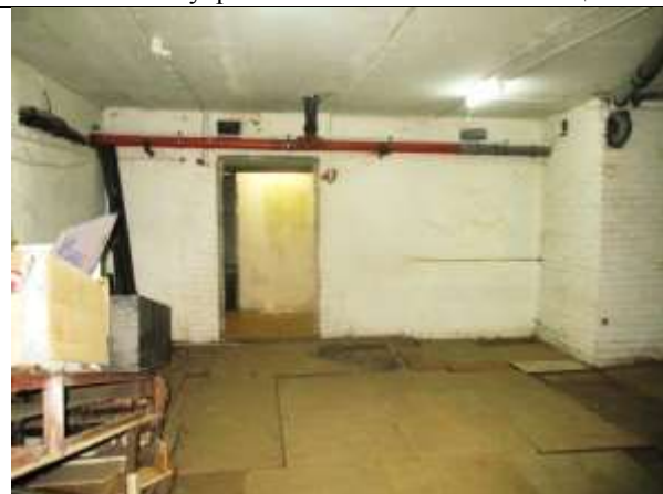
Фото 35. Внутреннее состояние Объекта оценки
