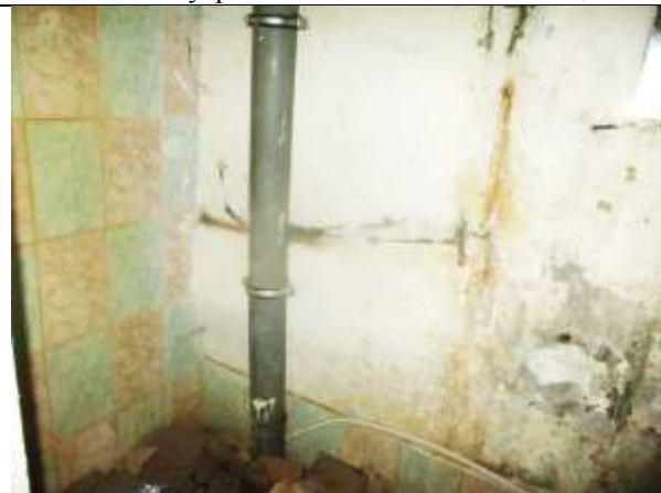
Фото 39. Внутреннее состояние Объекта оценки
