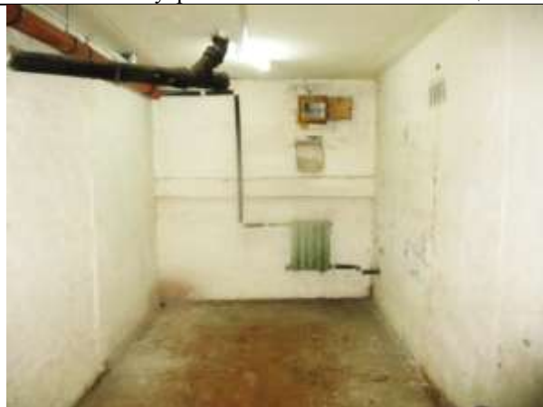
Фото 30. Внутреннее состояние Объекта оценки
