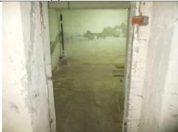
Фото 28. Внутреннее состояние Объекта оценки
