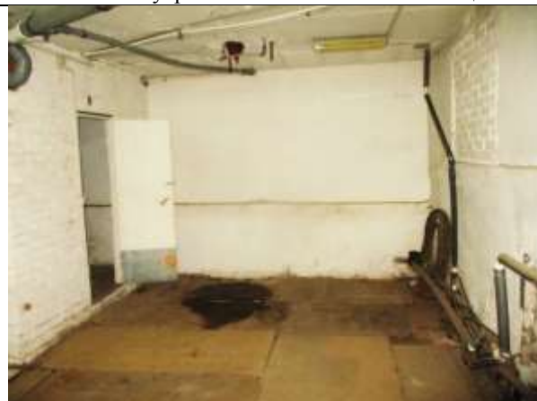
Фото 36. Внутреннее состояние Объекта оценки
