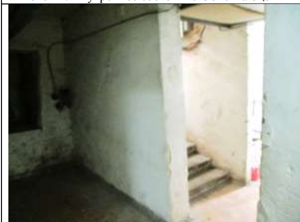
Фото 23. Внутреннее состояние Объекта оценки
