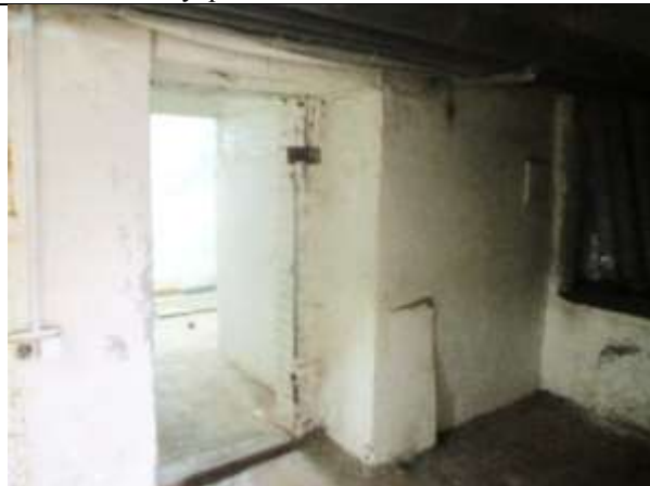
Фото 27. Внутреннее состояние Объекта оценки
