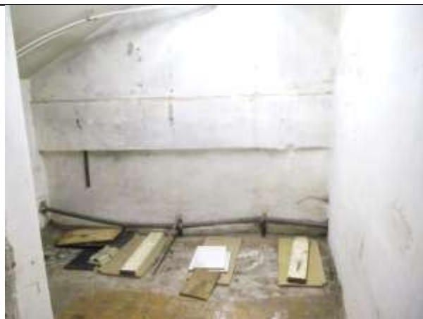
Фото 26. Внутреннее состояние Объекта оценки
